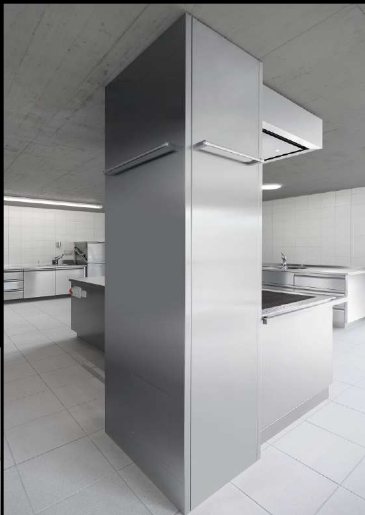
Säule komplett in Edelstahl verkleidet
